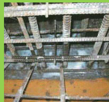
ジョイントエース散布後
