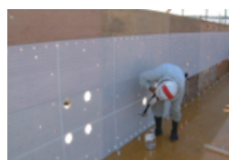
型枠への貼りつけ
