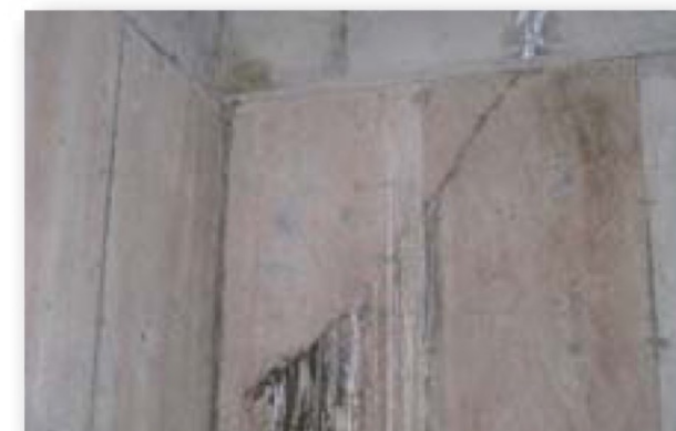
■ひび割れからの漏水
