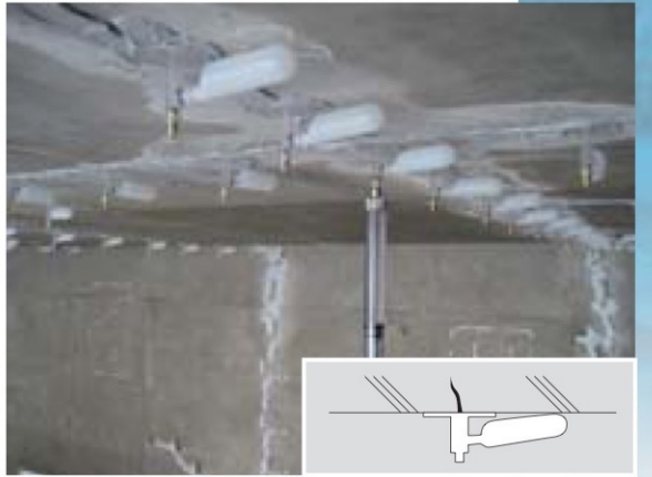
● 上げ裏面への施工例
