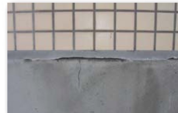
■シーリング材の劣化・剥離
