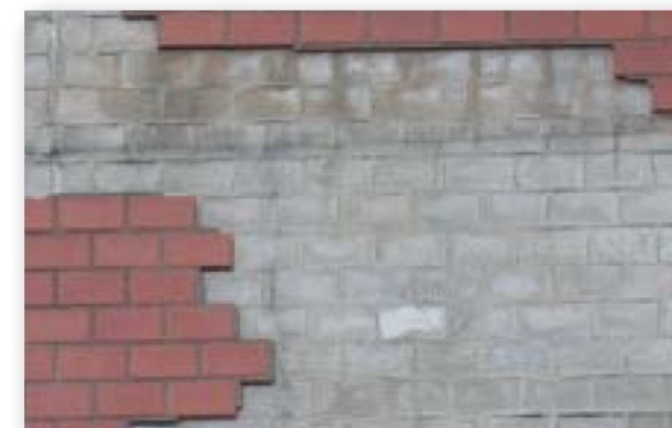
■ひび割れからの漏水
