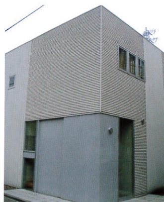
ガルバリウム（屋根・外装・内装一部）
