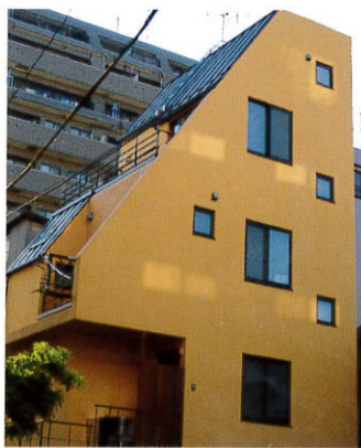
RC住宅（外装・内装）
