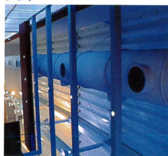
（断熱・防露・送風音対策）
