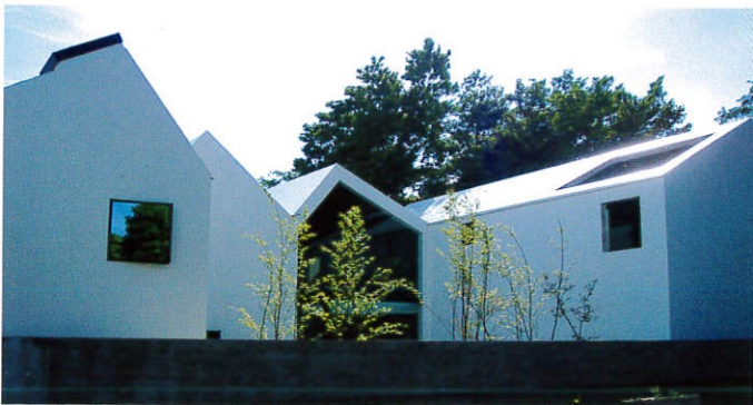
RC住宅（外装・内装）
