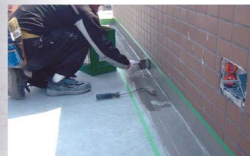
打継ぎ塗膜処理
