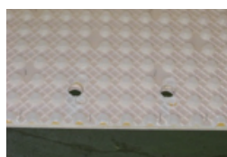
貫通孔の施工例
