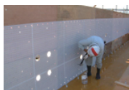
型枠への貼りつけ
