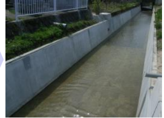
③施工完了
