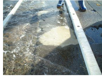
③施工完了
