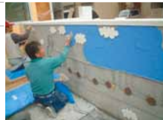
テクノカラーで広い面のコテ塗り
